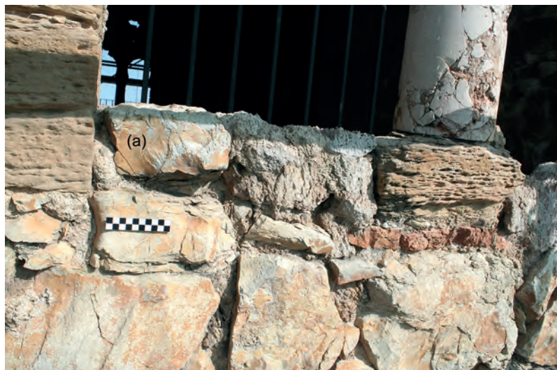
Fig. 59: Planta Tercera, Ajimez 2 (exterior). Detalle de la fábrica original conservada (a), una de las relaciones de estratigrafía muraria que demuestran que las plataformas de las cámaras de los ajimeces estaban niveladas con el arranque inferior de las columnas.
