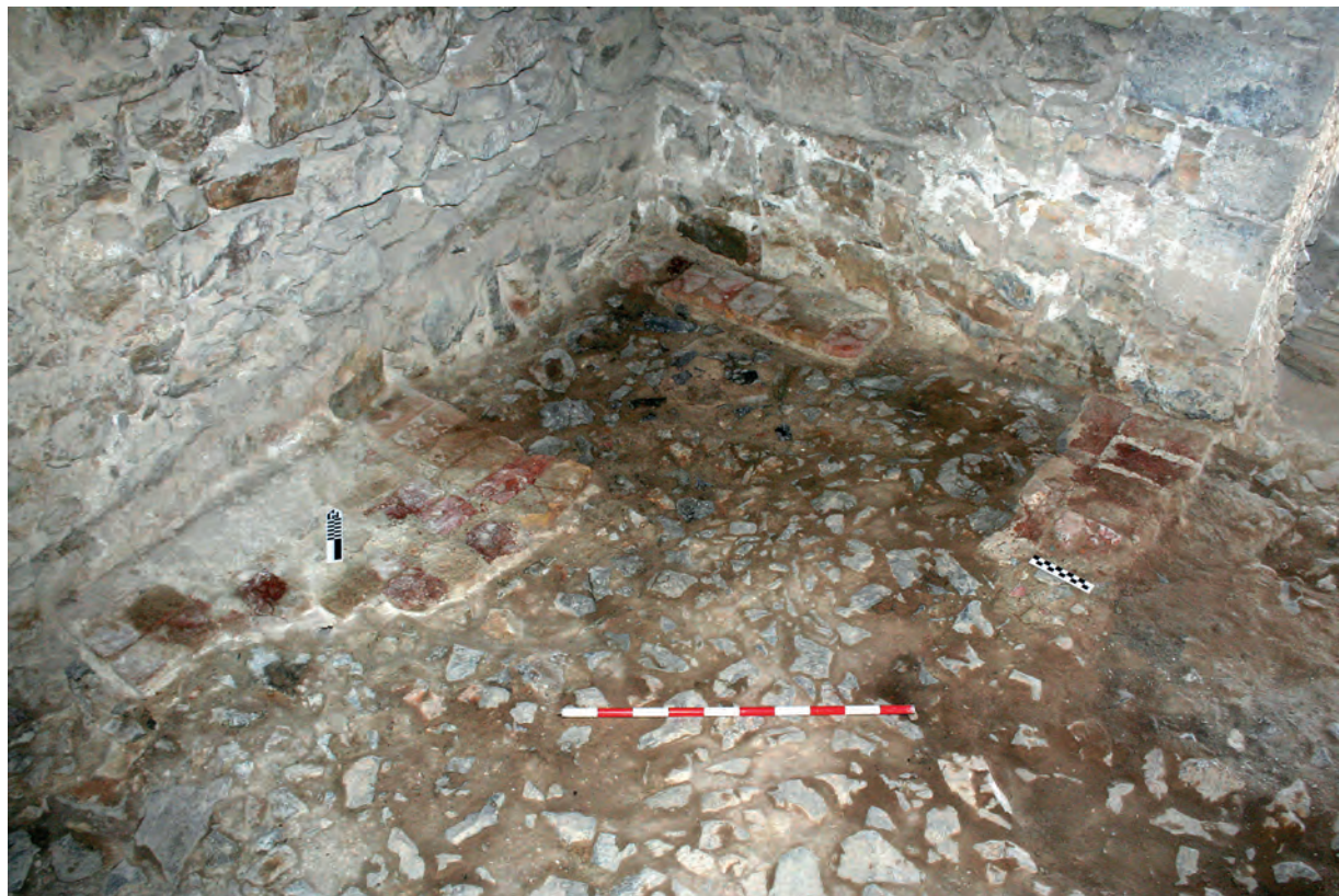
Fig. 33: Planta Tercera. Vista general de los restos de la escalera primitiva de época calatrava (s. XIII), en ladrillo, dispuestos sobre el pavimento original de la sala (empedrado de caliza).
