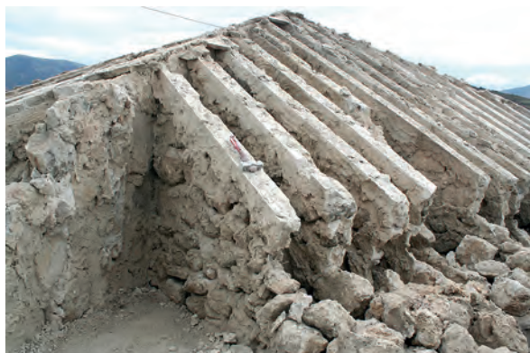
Fig. 11: Terrado. La cubierta en proceso de desmantelamiento, con empalomado que soportaba cuatro faldones.
