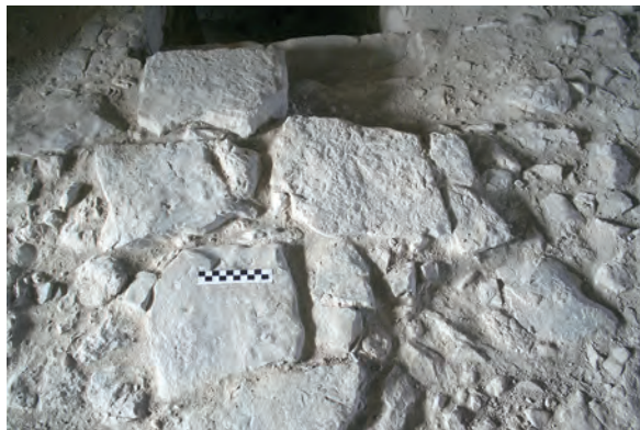
Fig. 68: Planta Tercera. Pavimento original de la sala (s. XIII), con empedrado dispuesto sobre el migajón de la torre, que incorpora varias losas de piedra en el desembarco de la escalera primitiva.
