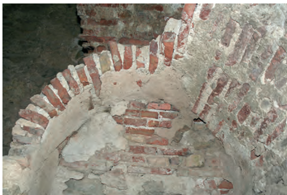
Fig. 64: Paso original (s. XIII) entre las plantas Segunda y Tercera, antes de la intervención. Bóveda U.E. 103. Los enlucidos de yeso no corresponden a la fase fundacional.
