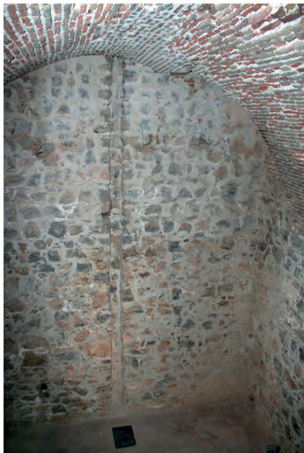
Fig. 61: Planta Segunda. Bóveda de ladrillo y despiece de la disposición latericia, con alternancia de A y B en el grueso de la rosca. Este mismo esquema se repite en la Planta Tercera.
