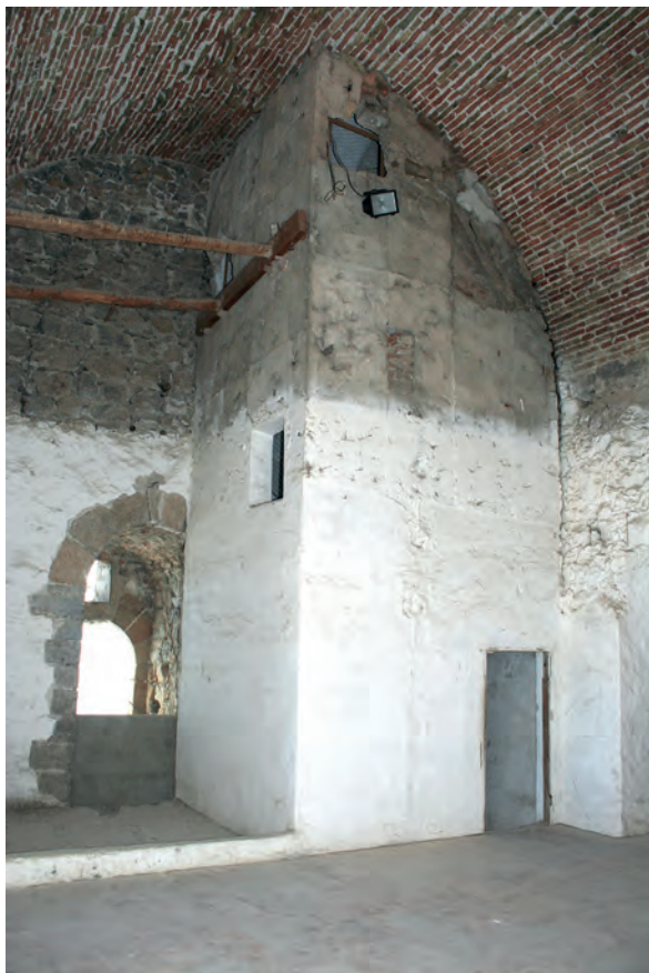
Fig. 71: Planta Segunda, antes del inicio de las obras. Caja de escalera del siglo XVI (U.E. 500) que vino a sustituir a la medieval original, dañando las bóvedas de ladrillo y reordenando la circulación interior de la torre. A la izquierda, la entrada medieval original (s. XIII).
