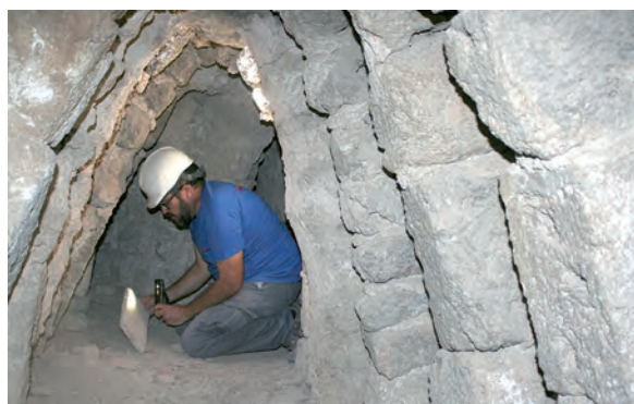
Fig. 9: Terrado. Galería transitable bajo la cubierta de teja, con cuatro tramos paralelos a cada una de las fachadas, antes de su dismantelamiento.
