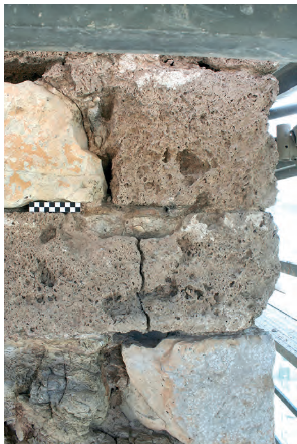
Fig. 36: Esquina entre las Fachadas 1 y 4, detalle de la parte superior. Refactio con sillería de travertino de la esquina original labrada en caliza.
