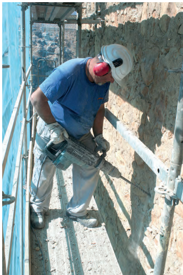
Fig. 7: Los cosidos estructurales de la torre han sido las acciones que han requerido una mayor inversión de tiempo y presupuesto del proyecto de consolidación.
