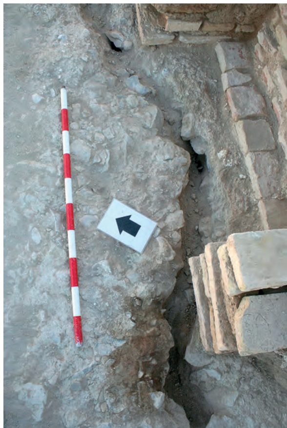
Fig. 6: Terrado. Las grietas estructurales localizadas durante la ejecución de los trabajos que se pueden relacionar con los efectos provocados por movimientos sísmicos históricos son abundantes y, en ocasiones, de una patología extrema.
