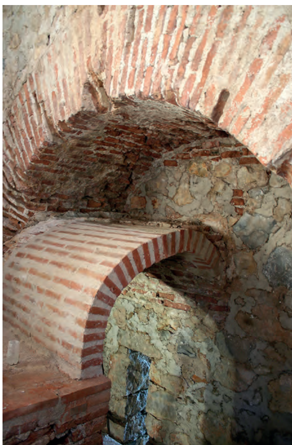
Fig. 65: Arco de descarga (U.E. 229) en el paso original (s. XIII) que comunicaba las plantas Segunda y Tercera, con bovedita U.E. 104 (parcialmente reconstruida) y aspillera.
