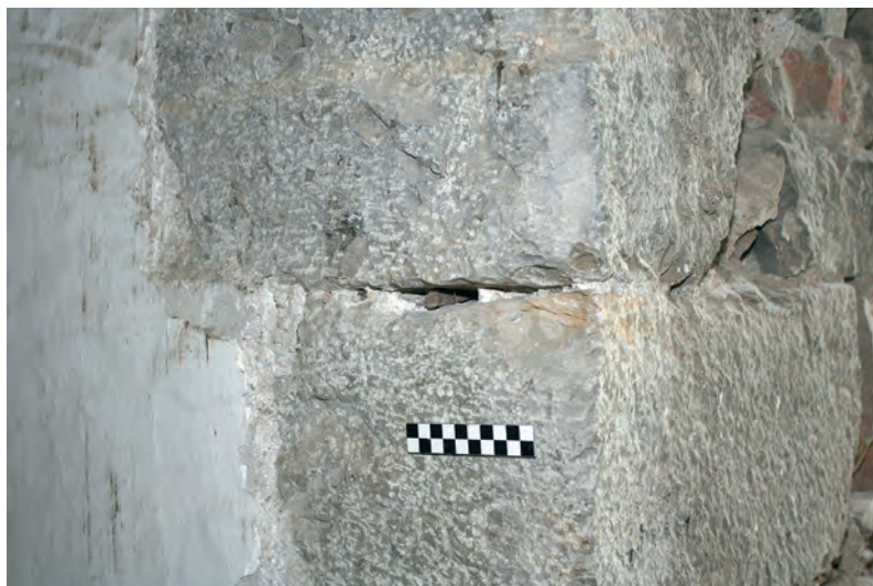
Fig. 41: Planta Segunda. Detalle de la esquina interior de la puerta original de entrada, con cuña de madera in situ.
