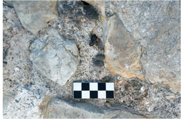
Fig. 49: Fachada 4. Punta nº 7 en su posición de impacto.
