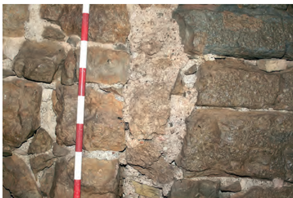
Fig. 69: Planta Tercera. Amortización con mampuestos y mortero de yeso (U.E. 266) de la mortaja del bajante de atanores que conducía las aguas pluviales al aljibe de la planta inferior de la torre.
