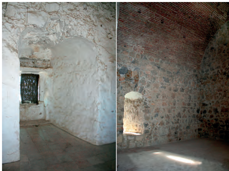
Fig. 74: Planta Segunda. Estado anterior y posterior a los trabajos realizados, con recuperación de ventana aspillera original (s. XIII) y eliminación de enlucidos y encalos sin interés.
