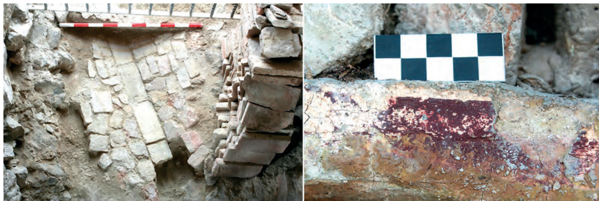
Fig. 58: Planta Tercera, cámara del Ajimez 4. A la izquierda, plataforma medieval dismantada (al igual que las otras tres) y pavimento de ladrillo U.E. 206 postmedieval con canalización que evacúa al exterior de la torre las aguas pluviales filtradas desde la cubierta. A la derecha, ladrillo original del siglo XIII reutilizado, con restos de mortero con pigmento rojo.
