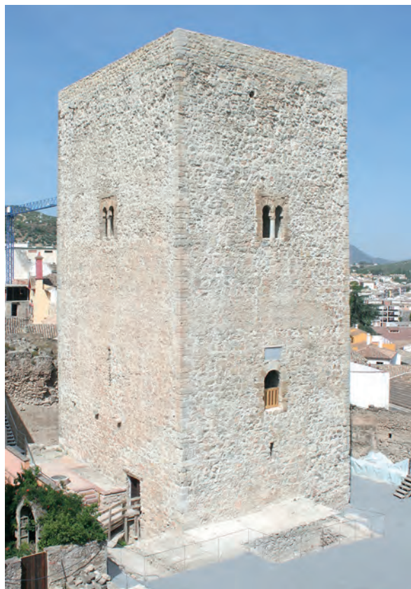
Fig. 3: Panorámica general de la torre al término de los trabajos de consolidación.
