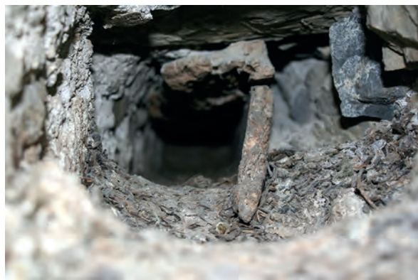
Fig. 55: Planta Tercera. Ajimez 2. Restos de madera pertenecientes a la caja o mortaja del alamud.
